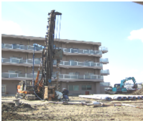
パイル打ち工事＝9月25日、撮影
