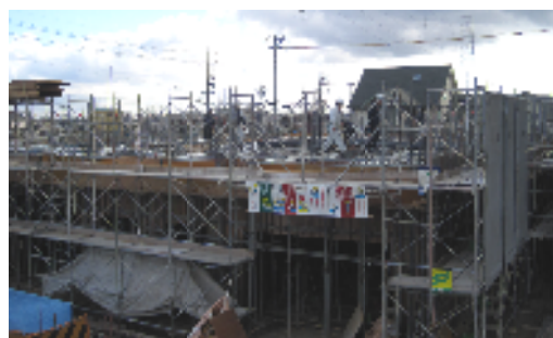
11月24日、撮影 2階部分コンクリート敷設工事
