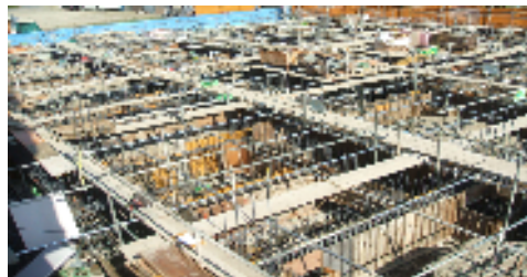
基礎工事用パネル敷設＝10月10日、撮影
